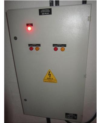
Quadro elétrico de acionamento e controle dos ventiladores
